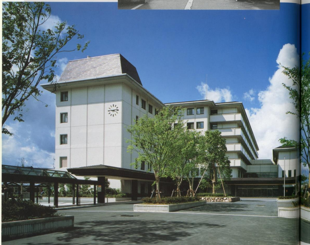
1 市立病院 ●平和町3丁目●平成1年 ●本館鉄骨造(一部鉄骨鉄筋コンクリート造)地下1階・地上6階建●17,596㎡ ●東館鉄骨造5階建●1,255㎡
